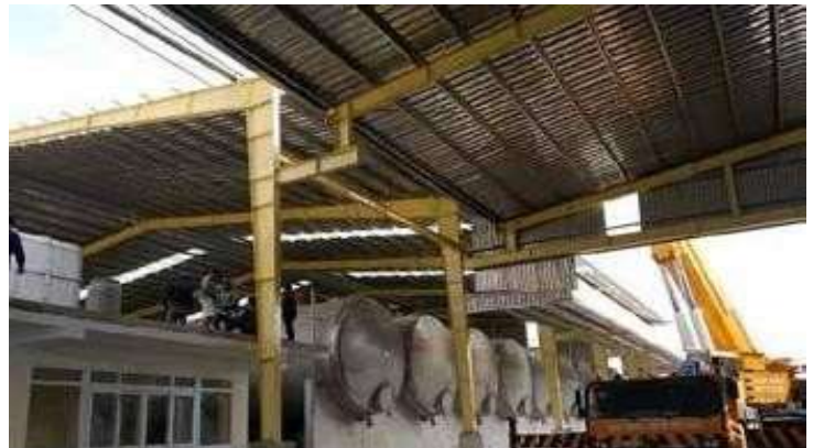
NHÀ MÁY MŨ LATEX MAI VĨNH/ MAI VĨNH LATEX FACTORY
