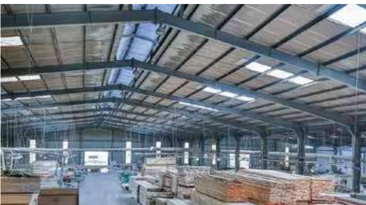
NHÀ MÁY GỖ LONG NGUYÊN/ LONG NGUYEN WOOD FACTORY
